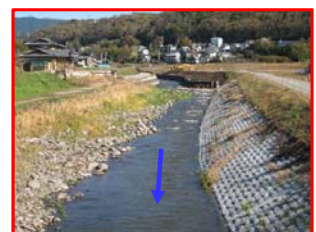
来光川堤防整備・護岸整備(県)
