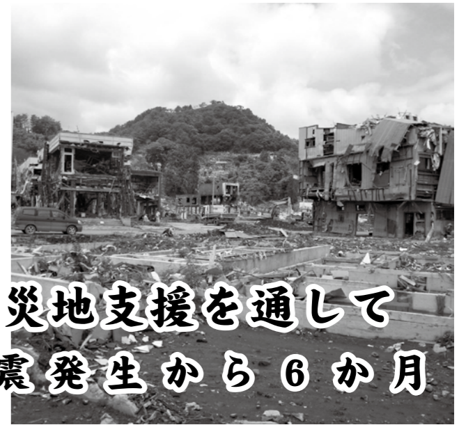
▲津波により町が壊滅している状況 (岩手県山田町)
