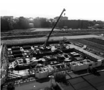
▲(仮称)図書館等複合施設の工事の様子
