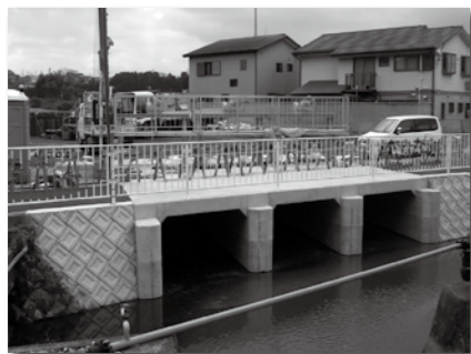
▲大洞川放水路設置工事
