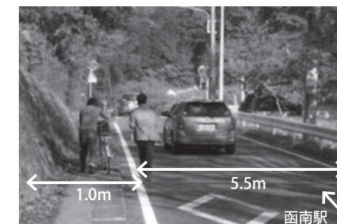
▲整備前の道路の状況
