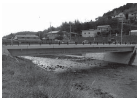
▲平成27年度に完成した観音橋
