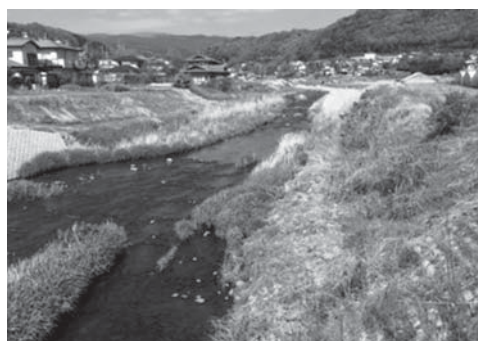
▲整備中の観音橋上流
