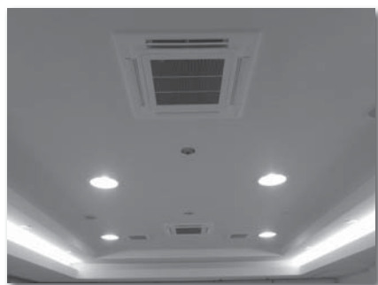
▲空調設備の設置を進める教育施設
