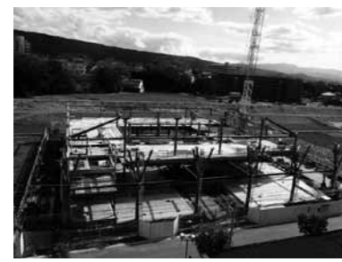
▲建設途中の（仮称）図書館等複合施設
