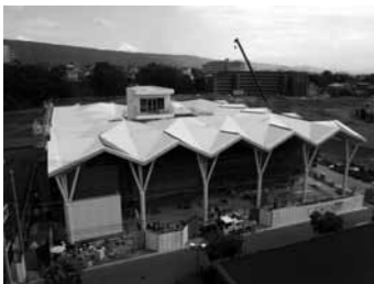
▲建設途中の(仮称)図書館等複合施設
