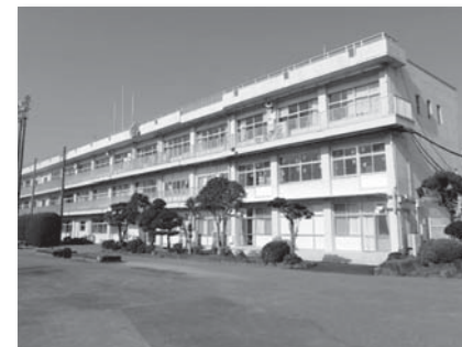
▲大規模改修を行う函南中学校
