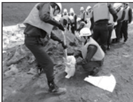
演習参加者全員で土のう作り後、各市町消防団による水防工法を実施
