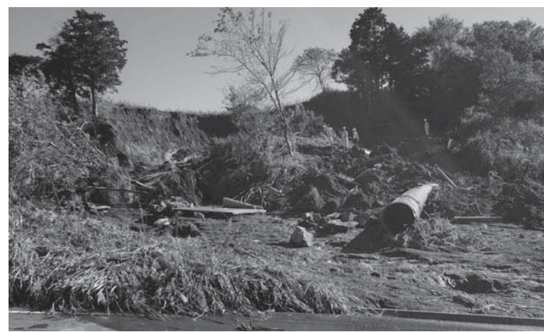
▲台風により破断された県営駿豆水道送水管
