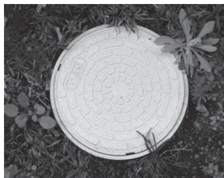
▲汚水まます例(塩化ビニル製)
