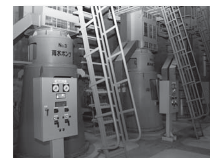
▲更新整備を行う排水ポンプ
