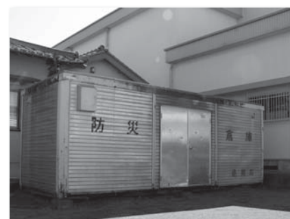
▲更新予定の防災倉庫
