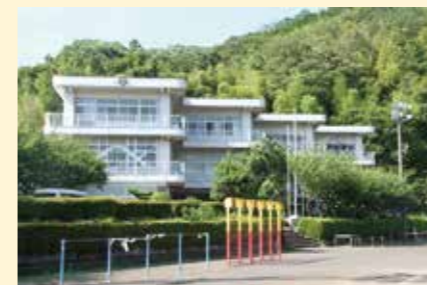
▲採光に配慮した丹那小学校の校舎
