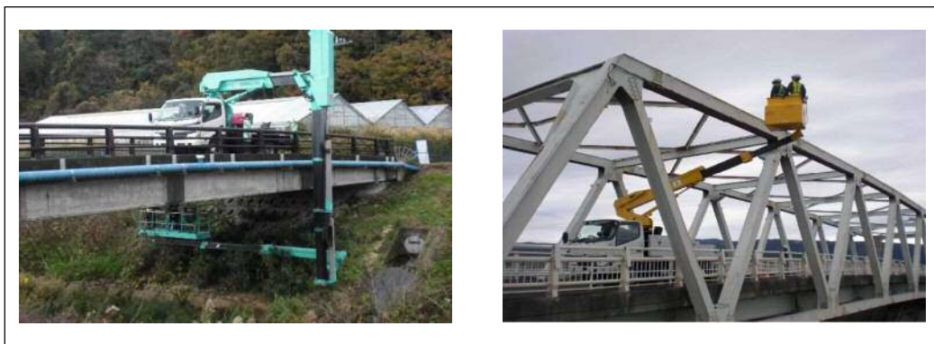
写真 4.1 定期点検状況
