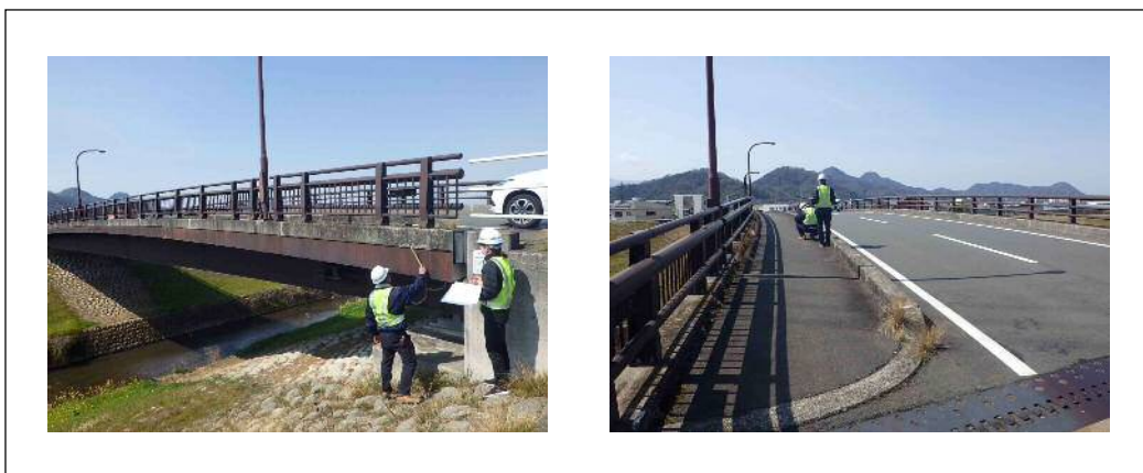
写真 4.2 日常の維持作業状況
