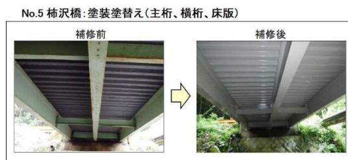
写真 1.1 補修状況写真
