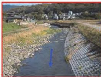
来光川堤防整備・護岸整備(県)
