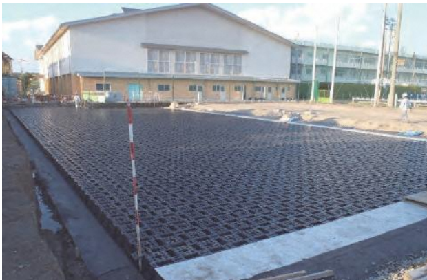
函南中学校テニスコート地下式調整池設置工事
