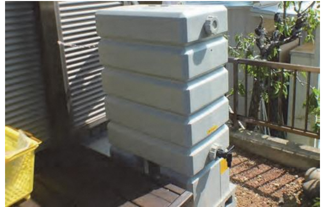
雨水貯留施設設置
