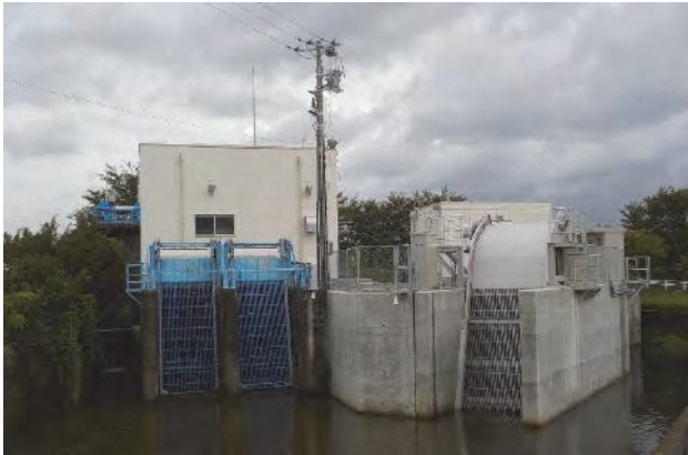
新田排水機場改修工事完成時
