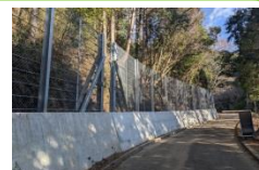
令和6年度設置 落石防護柵
