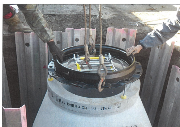
マンホールの設置状況
