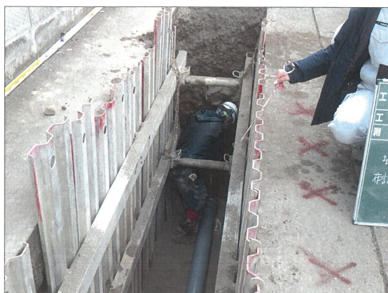
下水道管の埋設状況
