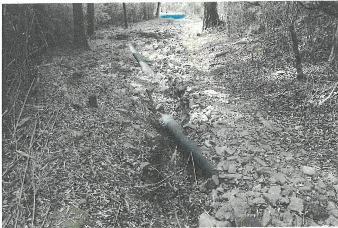
写真7 石畳・洗堀被害の現況
