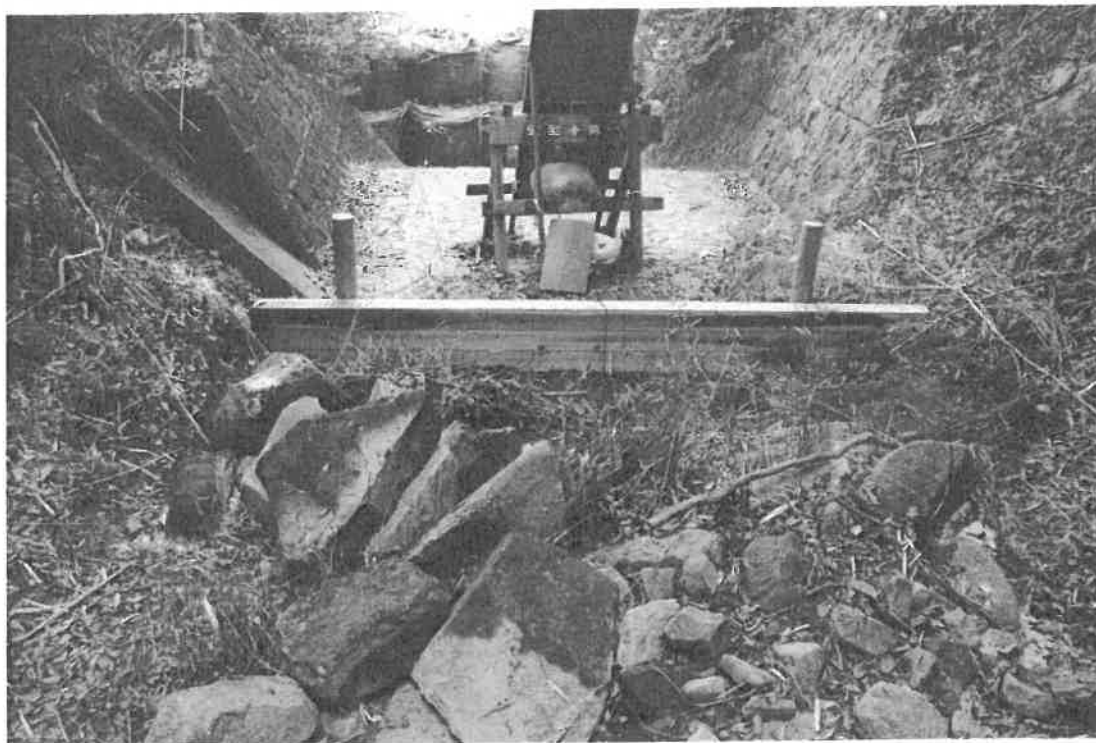
写真 11 木製柵設置状況
