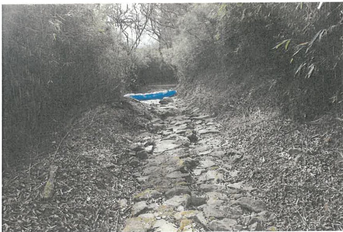
写真6 石畳現況 積み土嚢設置状況
