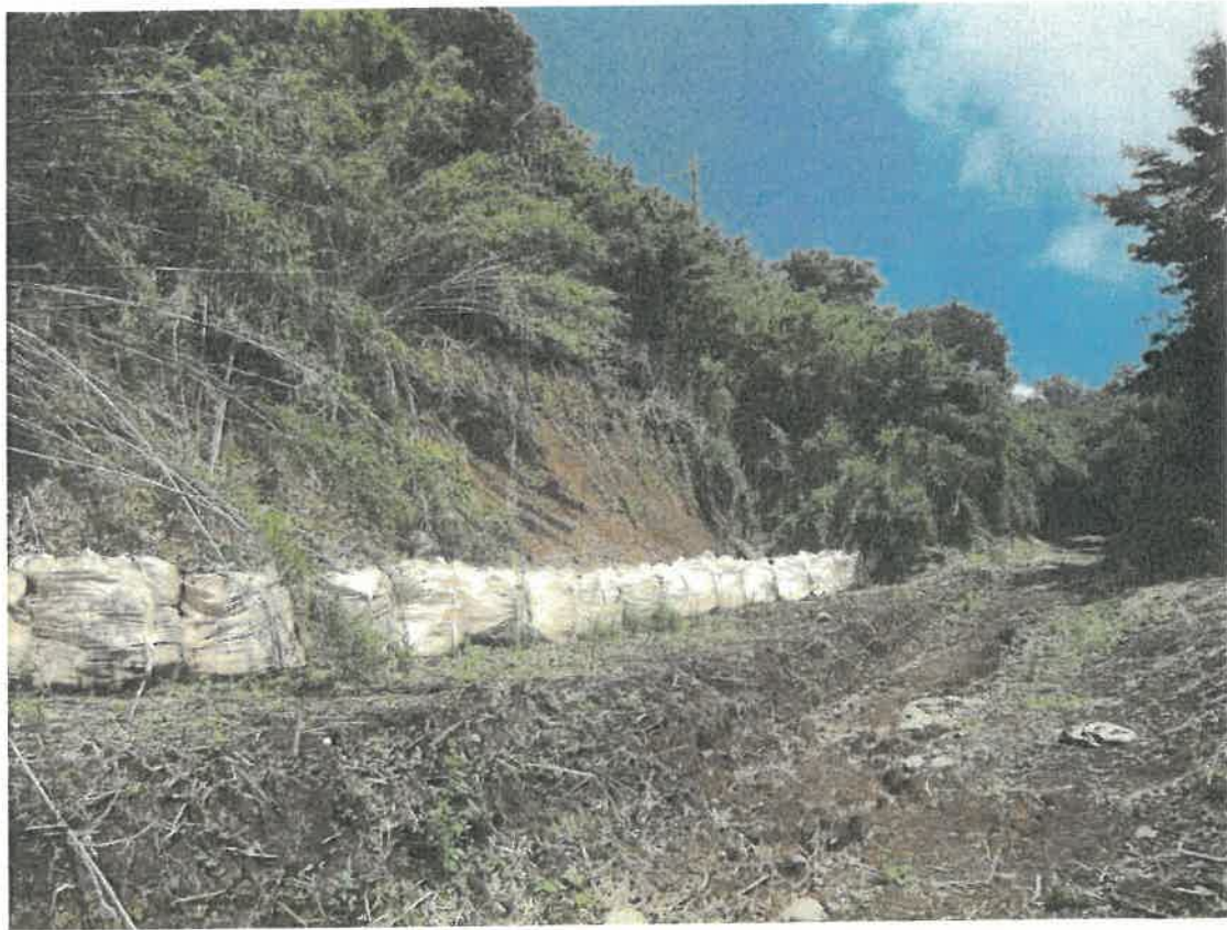
写真3 令和元年台風19号災害後の土砂崩れ復旧箇所
