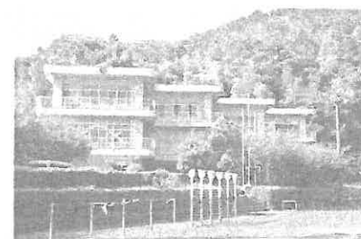
▲採光に配慮した丹那小学校の校舎
