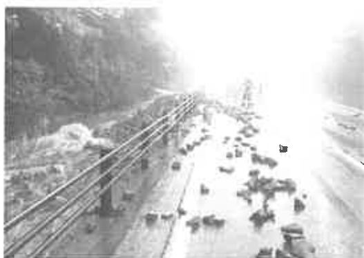
災害発生時の国道1号への石材（石畳）流出箇所（地点E）
