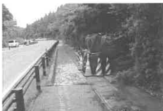
国道への土砂流出痕跡
