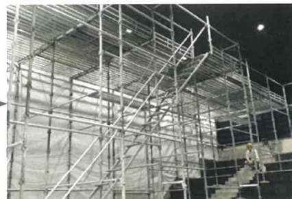
仮設工事 + 天井解体
