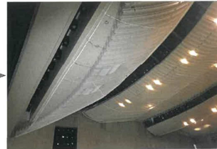
落下防止ネット設置
