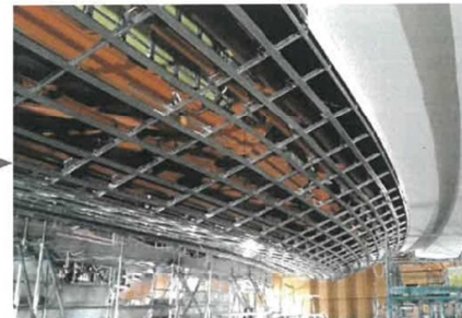
鉄骨設置 + 天井設置
