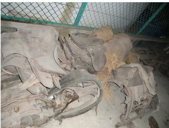
雨漏りの影響により、一部で腐食が認められる。
