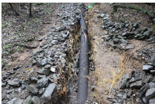
露出した埋設管の様子
