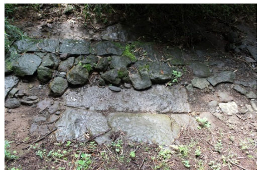
図 石橋(中央部はケーブル工事のため石材が滅失)
