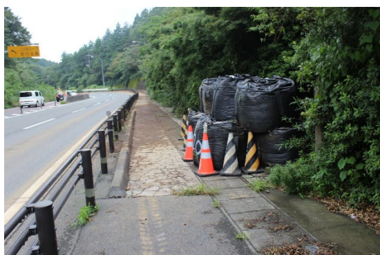
国道への土砂流出痕跡
