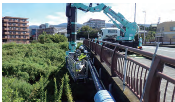
橋梁点検の様子
