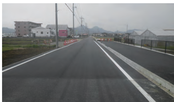
改良が進む町道 1-6 号線
