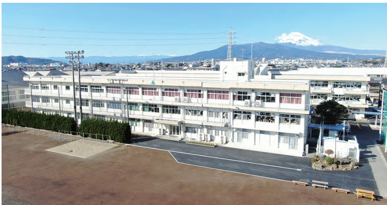
大規模改修後の函南中学校
