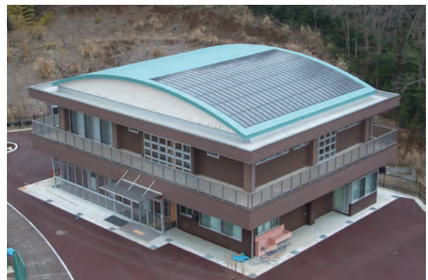
防災機能を備えた運動公園管理棟 (ソーラーパネル)
