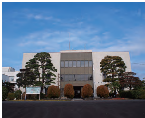
狩野川東部浄化センター
