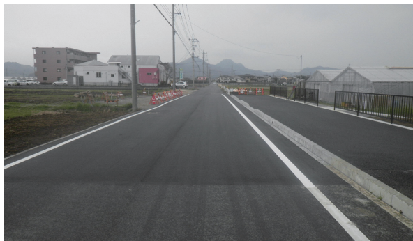
改良が進む町道 1-6 号線
