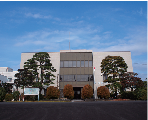
狩野川東部浄化センター
