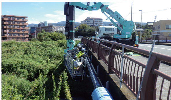
橋梁点検の様子
