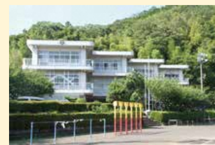
▲採光に配慮した丹那小学校の校舎
