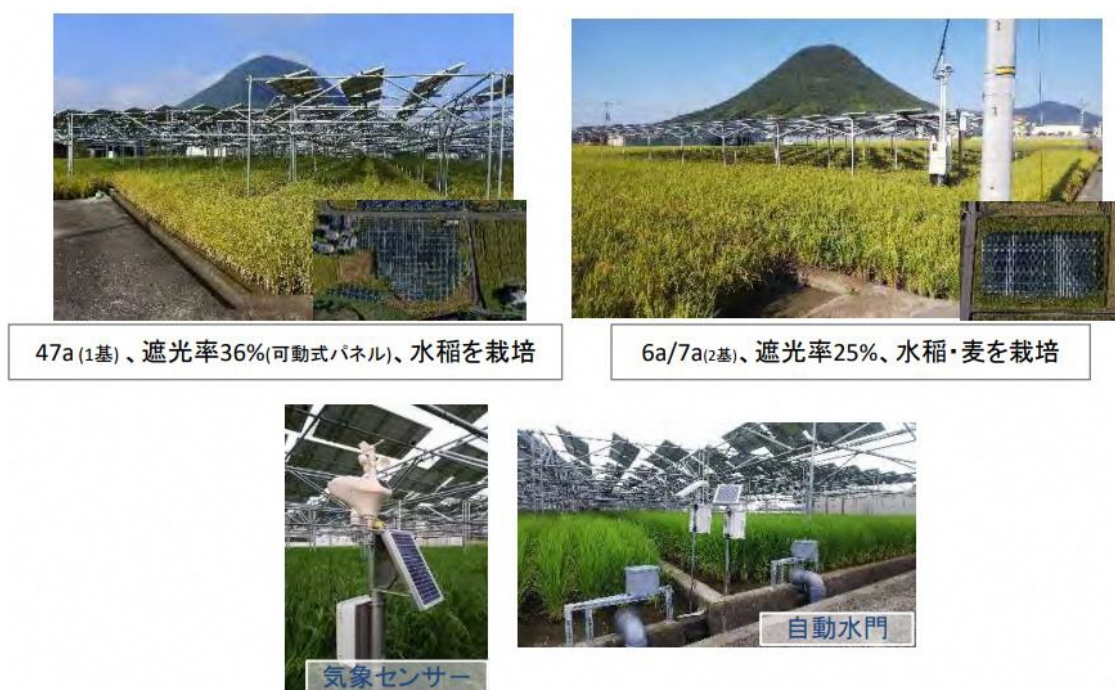
図 4-3 営農型太陽光の設置例 出典：農林水産業「営農型太陽光発電取組支援ガイドブック」
