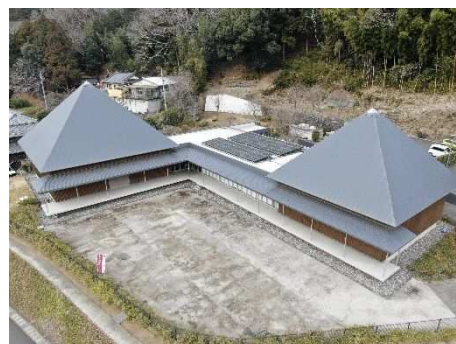
▲かんなみ仏の里美術館の太陽光発電設備
