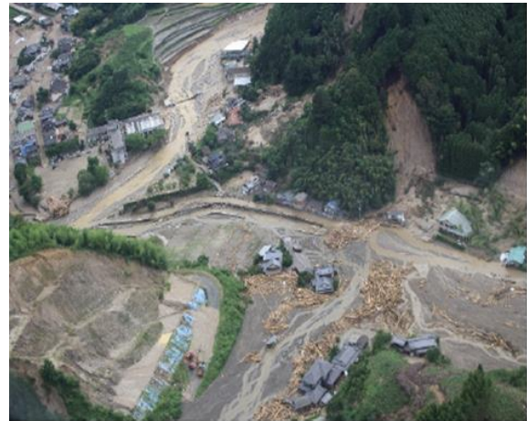
図 1-7 朝倉市松末地区の被害状況 （2017 年九州北部豪雨災害）
